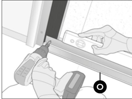
Montieren Sie nun das Starterprofil (O) an der Unterseite der Fassade in gleicher Höhe. Es ist sehr wichtig, dass das Starterprofil absolut eben ist.
